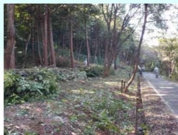
緩衝帯の整備
