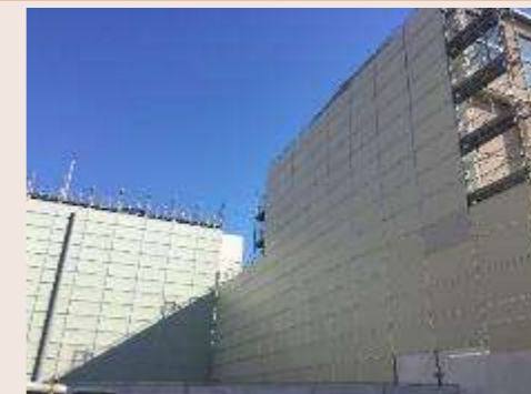
防音パネルの設置
