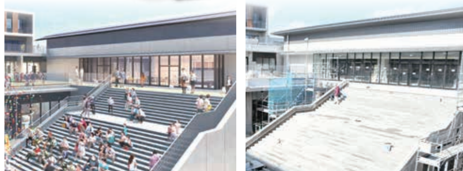
▲正面階段の完成予想図（左）と写真（右）が比較できるまで工事が進行しました。
