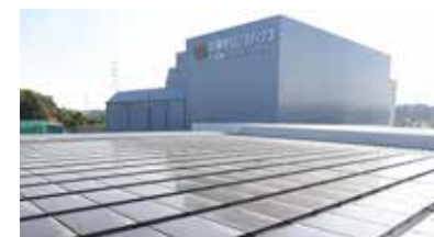
▲埼玉物流センターの太陽光発電システム。
