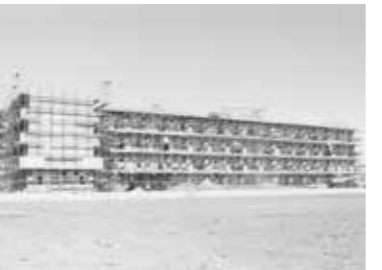
▶建設中の三芳東中(1977)
