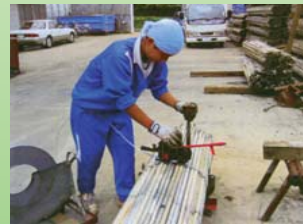
▶㈱矢島工務店：足場をつくる資材を束ねる作業中
