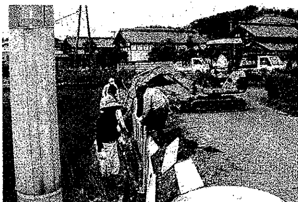
工事が始まった当初の市道
