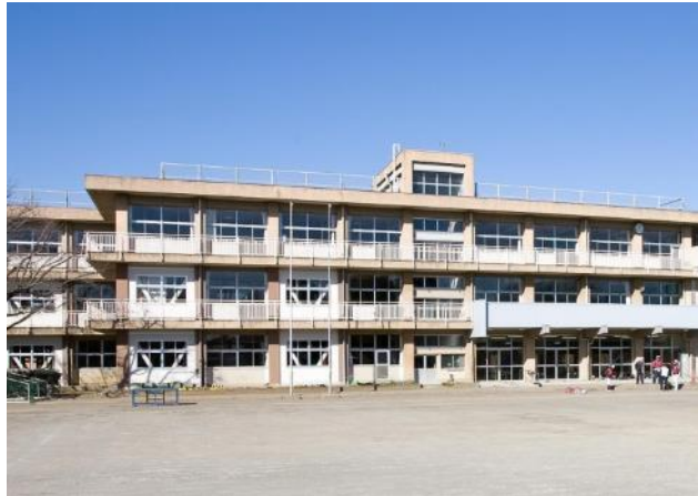
学校の耐震化(平成25年で完了)
