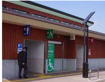
非常用電源付きトイレ
