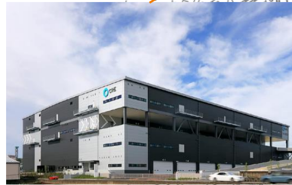
物流倉庫R2年6月竣工
