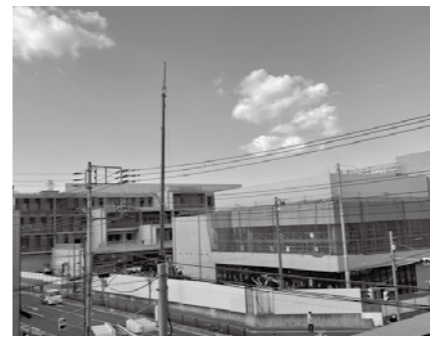
工事が進む藤久保地域拠点施設
