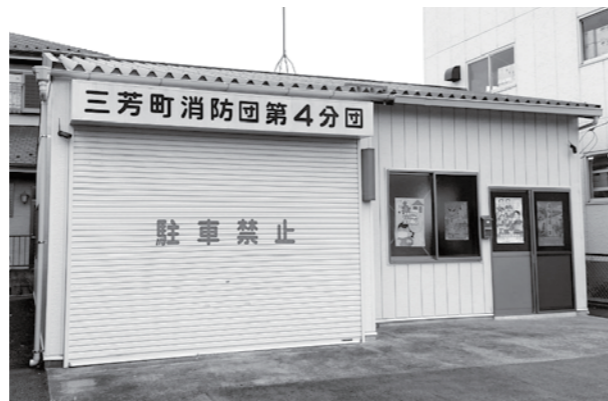
三芳町消防団第4分団車庫の改修工事が行われました。(1364万円)
