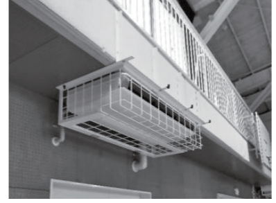
小中学校体育館へのエアコン機器の早期導入決定!
