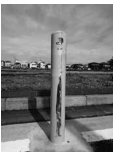
直されたばかりの鉄柱についた擦り痕
