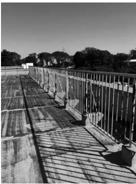
上富小学校屋上の手すり
