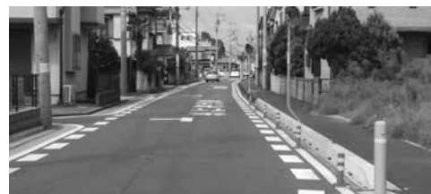
幹線5号線 の防護柵設 置箇所
