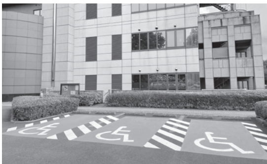
役場の車椅子駐車スペース
