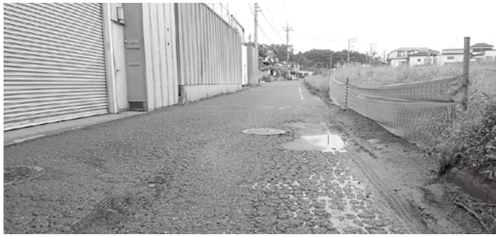
工事が予定されている内の1路線(町道幹線14号線)
