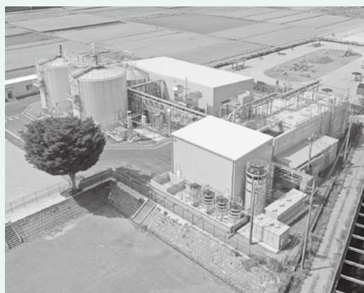
バイオガスプラント
