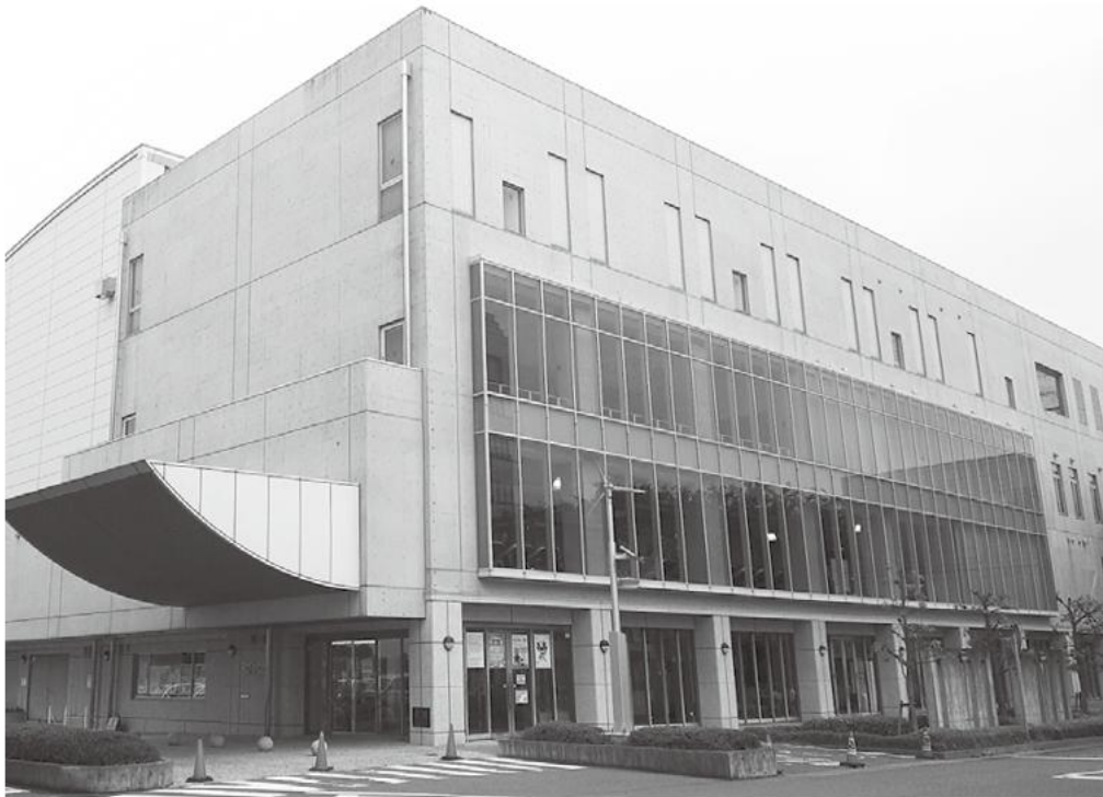
アリーナの修繕が行われる体育館
