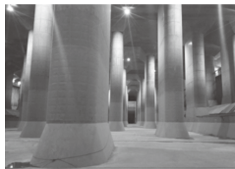
首都圏外郭放水路の地下調圧水槽
