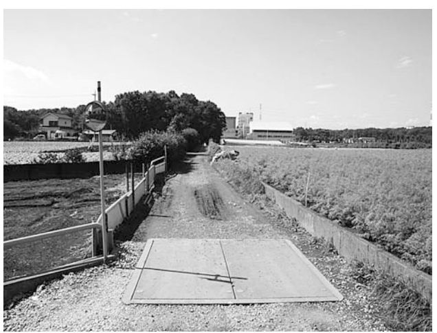
排水管工事が予定されている道路
