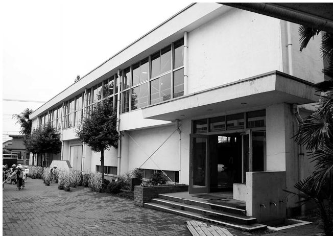
藤久保小学校体育館
