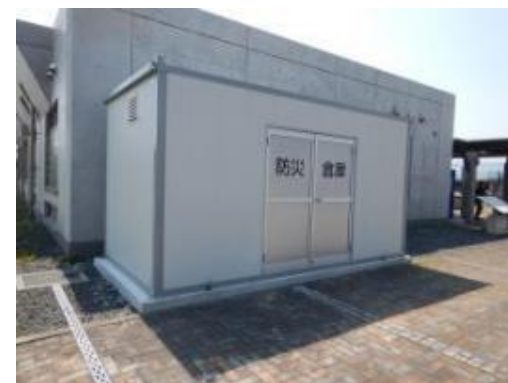
防災倉庫 道の駅しんよしとみ (上毛市)
