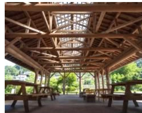
多目的利用可能な半屋外空間 道の駅果樹公園あしがくぼ （横瀬町）
