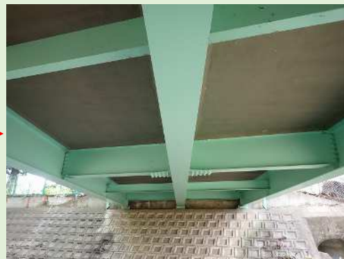
床版の補修、塗装の塗替え(東永橋)
