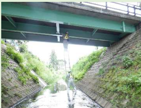
梯子による点検(東永橋)
