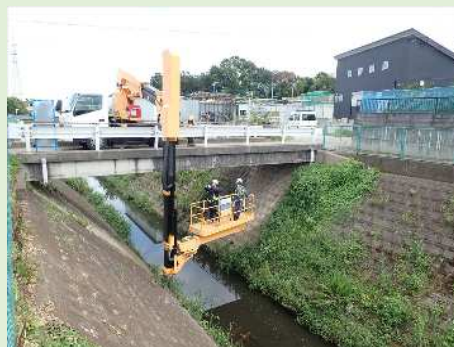
橋梁点検車による点検(永久保六橋)
