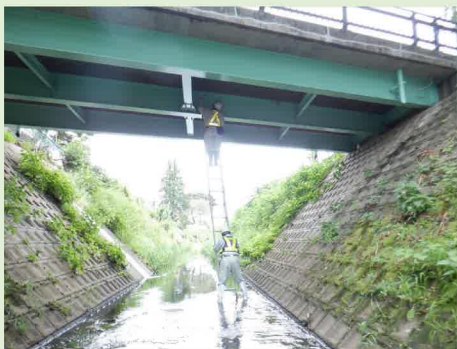
梯子による点検(東永橋)
