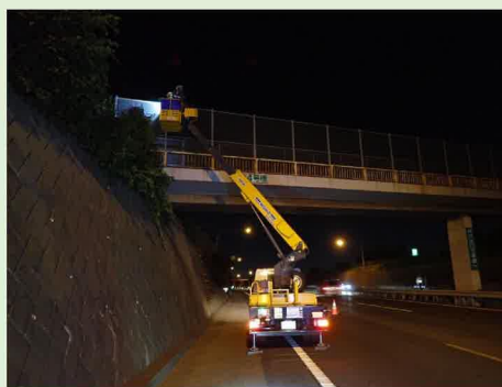
リフト車による点検(中東四号橋)
