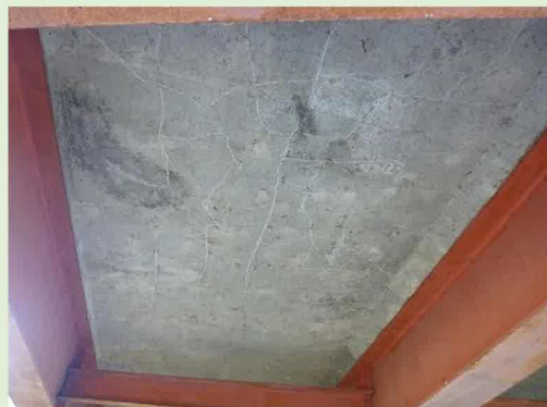
床版の補修、塗装の塗替え(東永橋)
