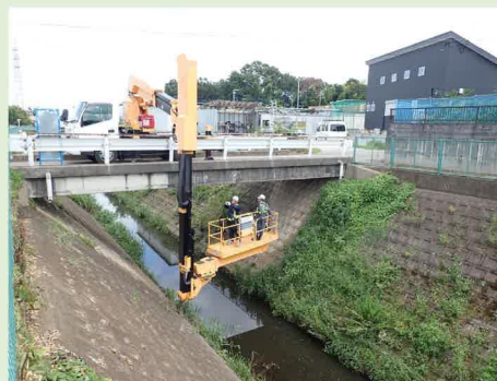
橋梁点検車による点検(永久保六橋)
