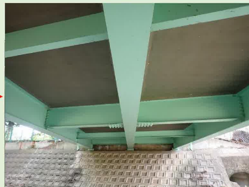
床版の補修、塗装の塗替え(東永橋)
