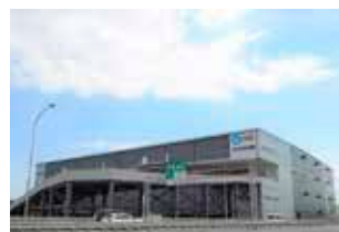
令和2年6月完成の流通業務施設
