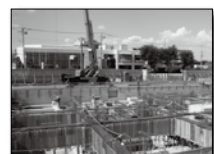
工事中の庁舎(9月撮影)
