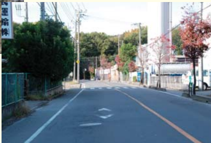
現在の町道幹線3号線(六間道)
