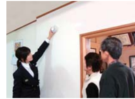
設置中にも、防火に関する多くの質問をいただきました。
