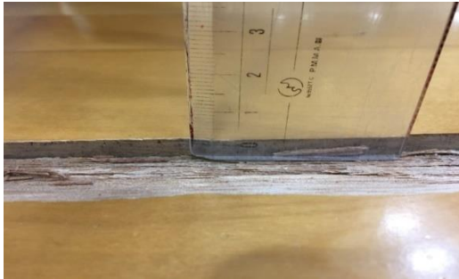
事故発生現場（深さ約 6mm）
