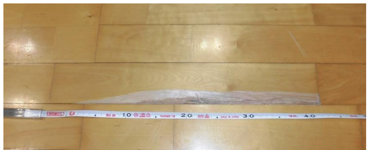
フローリングの剥離箇所 (約 420mm)
