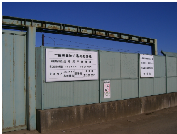
ふじみ野市一般廃棄物最終処分場
