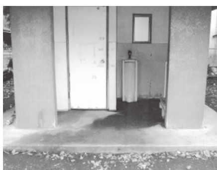
漏水している地蔵尊付近のトイレ
