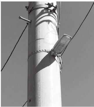
LED化された防犯灯
