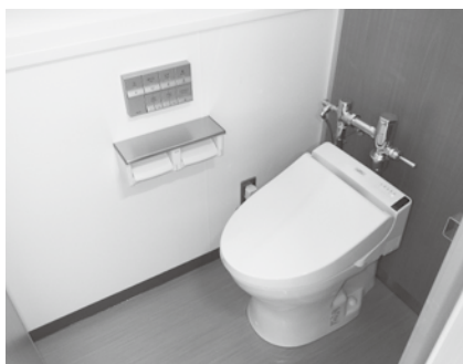
上富小学校のトイレが改修されます
