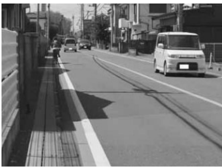
歩道が未整備の県道
