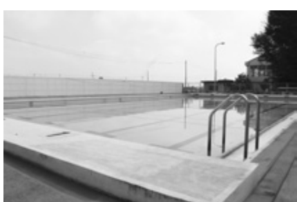
老朽化が進む小中学校のプール
