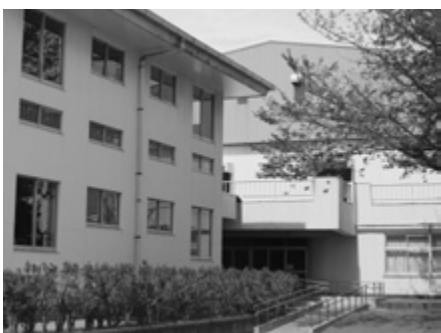
空調設置が望まれる体育施設
