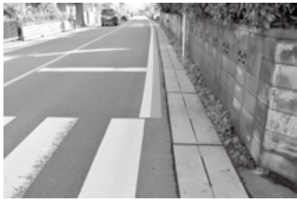
歩道が未設置の県道
