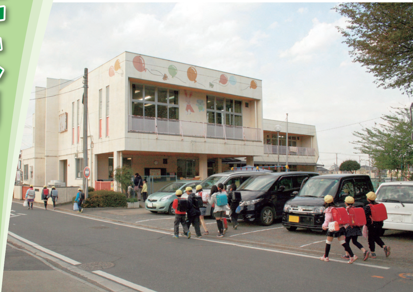
今年度耐震改修が予定されている第2保育所
