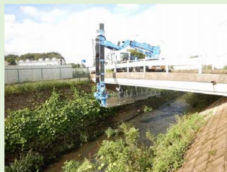
橋梁点検車による点検(東永三橋)
