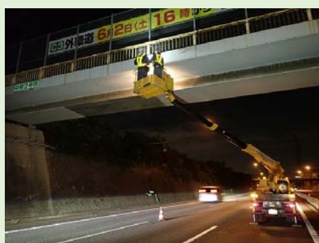
リフト車による点検(中東二号橋)
