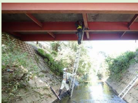
梯子による点検(東永橋)
