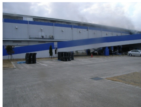
写真3-1-3 建物状況 (18日15時48分)
