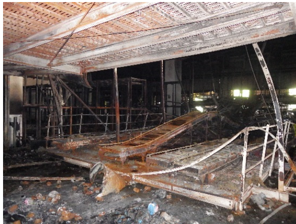
写真1-2-8 吊り下げベルトコンベヤ落下状態
