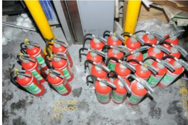
写真 1-2-2 消火器の使用状況
