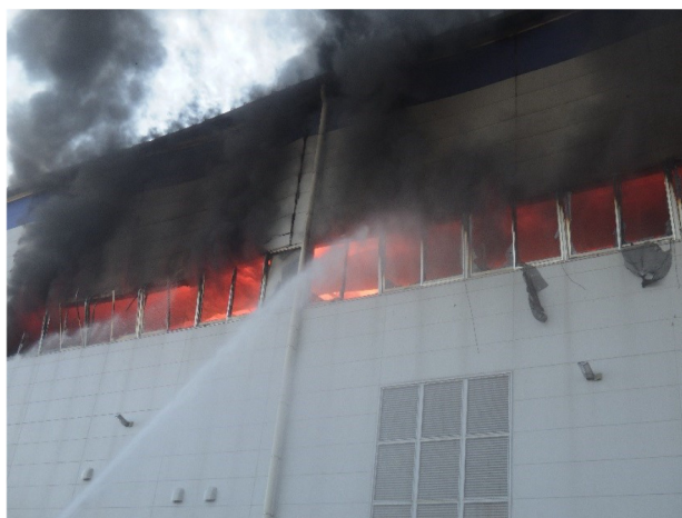
写真1-2-7 2階北側面の燃焼状態（2月16日10時頃）
