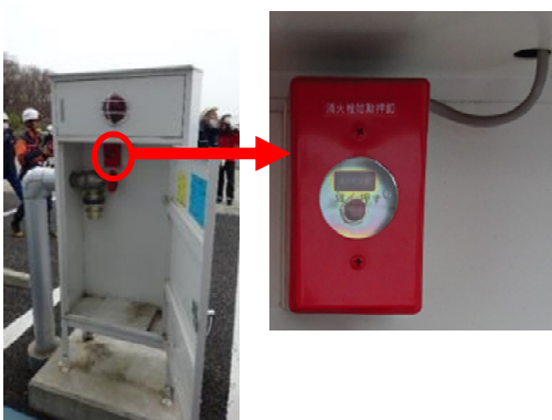
写真 1-2-3 端材室直近屋外消火栓起動ボタンの状況
