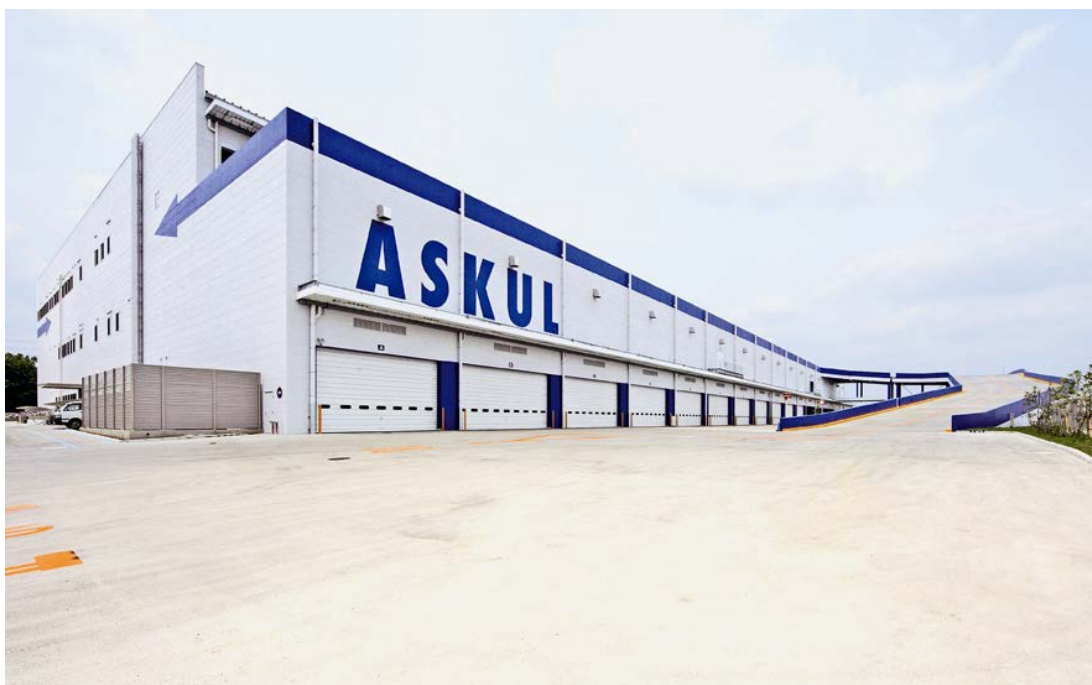
写真 1-1-1 倉庫全景（アスクル株式会社 2013 年 1 月 9 日プレスリリース資料から）
