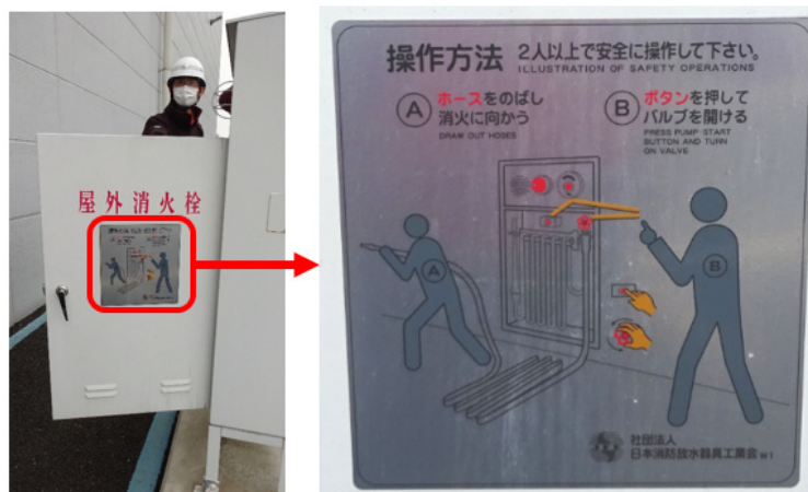
写真 1-3-3 屋外消火設備の操作方法
