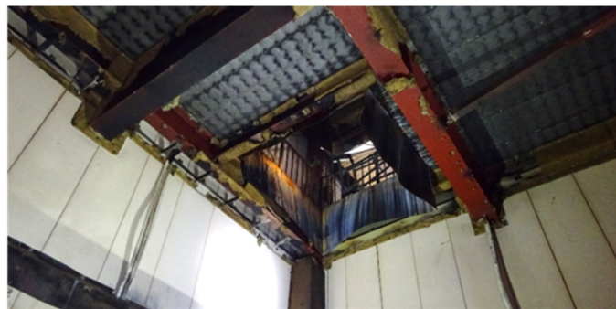
【1階端材室天井の開口部】
