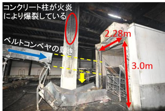
【端材室上部開口部（2階部分）付近】
