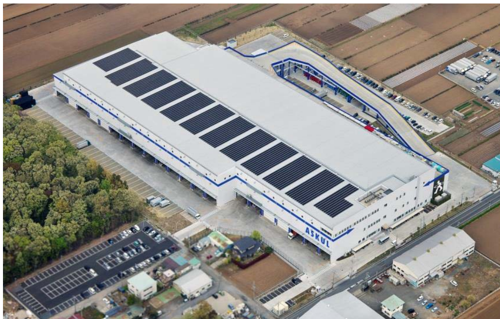
写真 1-1-9 屋根上敷設の太陽光発電モジュール(屋根上濃青色の部分) (上記プレスリリースより)
