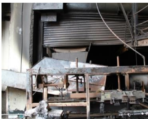
写真1-2-6 端材室2階部分東側の防火シャッター
