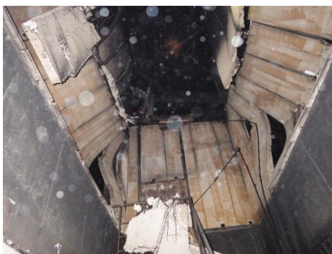
写真 1-2-9 階段室内 ALC パネル損傷状況
