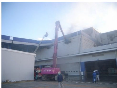
写真 3-1-8 開口部破壊状況 (17日 17時 13分頃)
