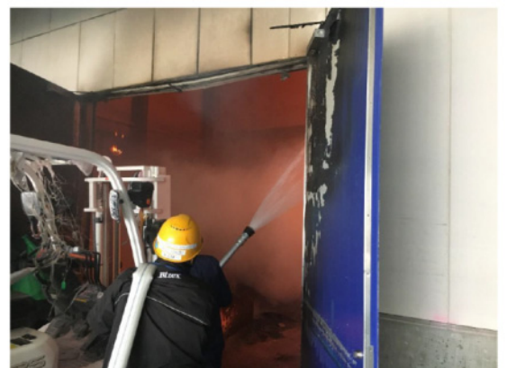
写真 1-2-4 端材室の状況 (9時20分)
