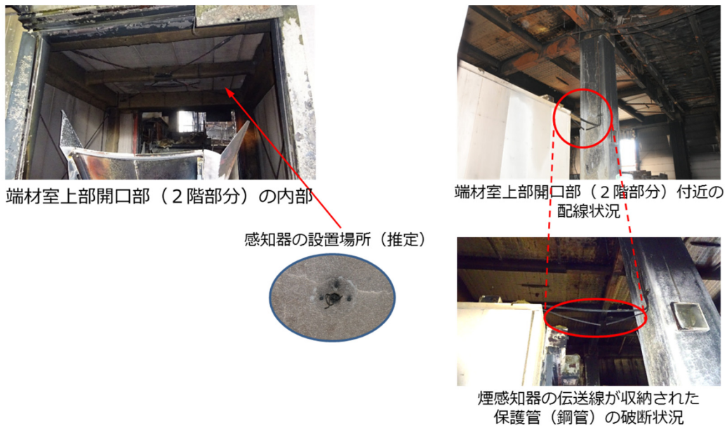
写真 2-3-2 端材室上部開口部
